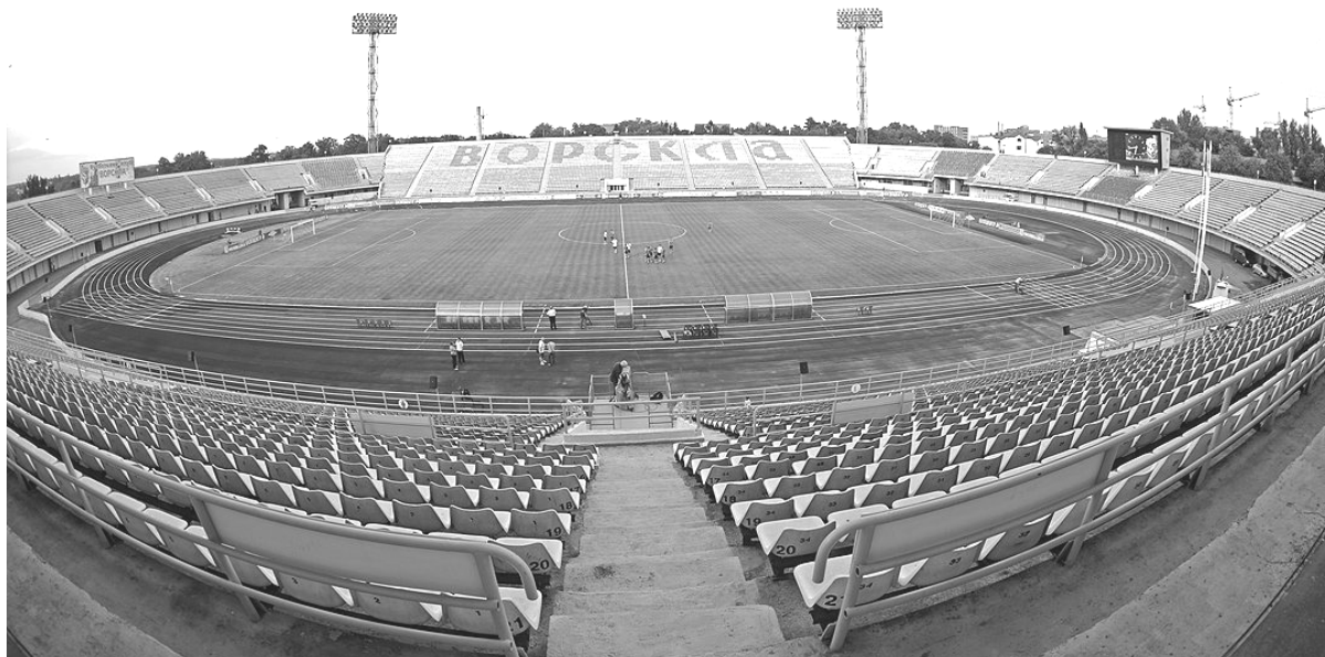
Рис. 1. Загальний вигляд трибуної споруди
